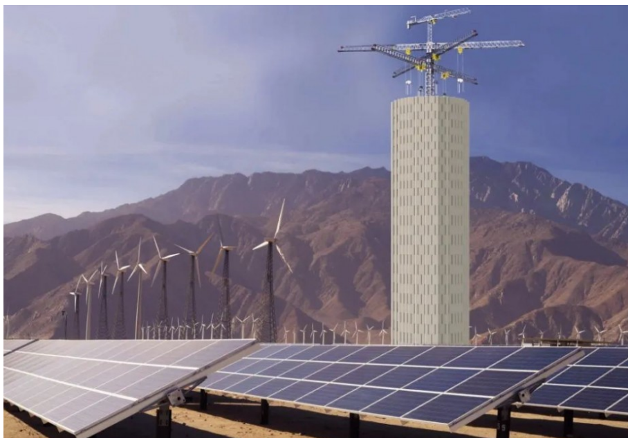
图 13 Energy Vault 公司光伏项目配套重力储能
